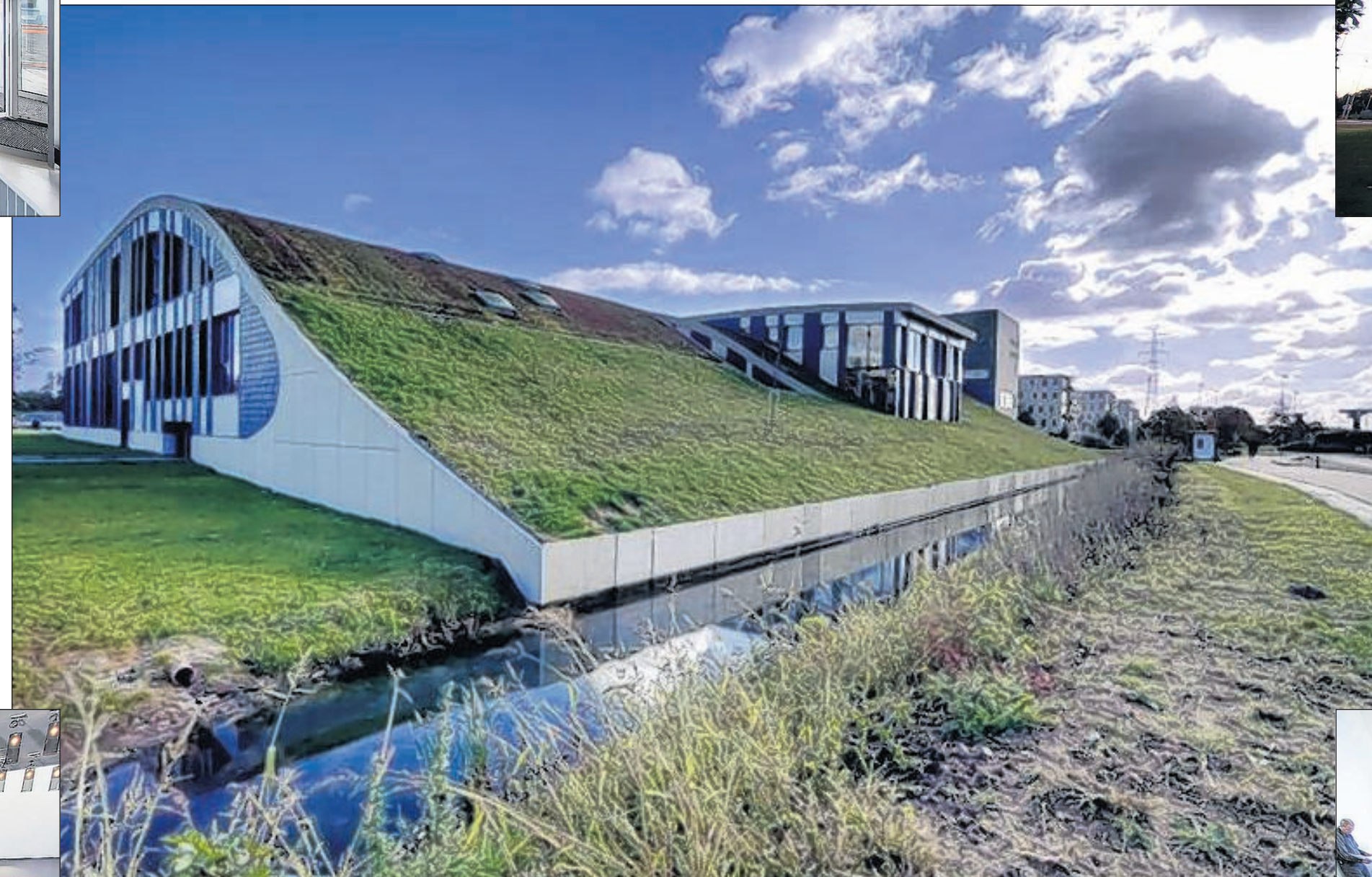
Het zicht vanaf de Energieweg. Het landschap is 'opgetild'. Het gras gaat over in sedum, een robuuste vetplant die vaak op groendaken is te vinden.
