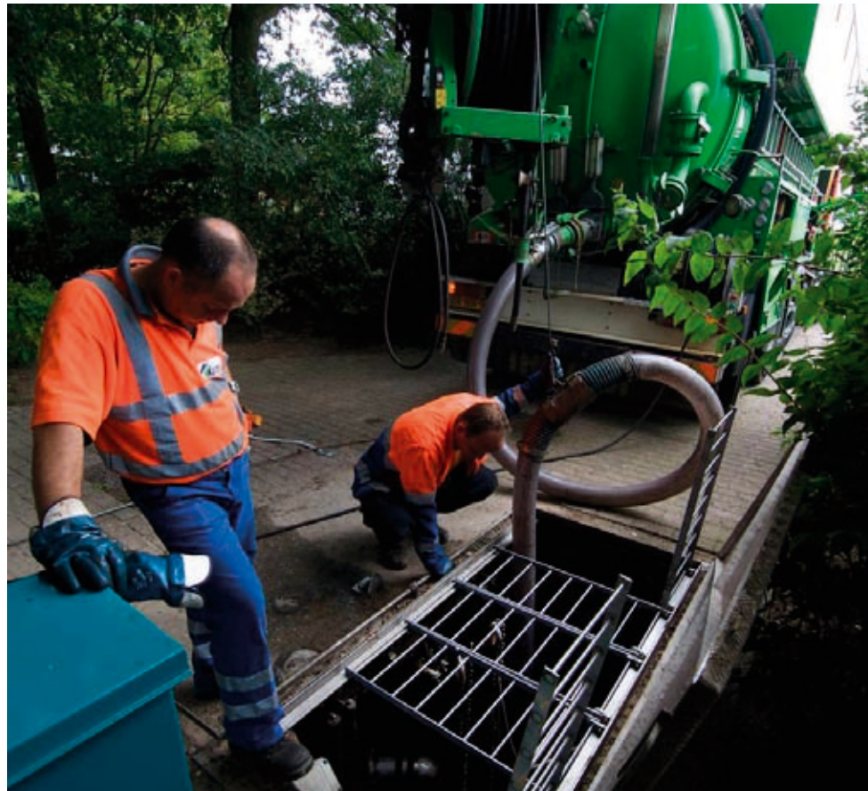
Schoonmaak bij de nieuwe ondergrondse pompen in Stokkum.
