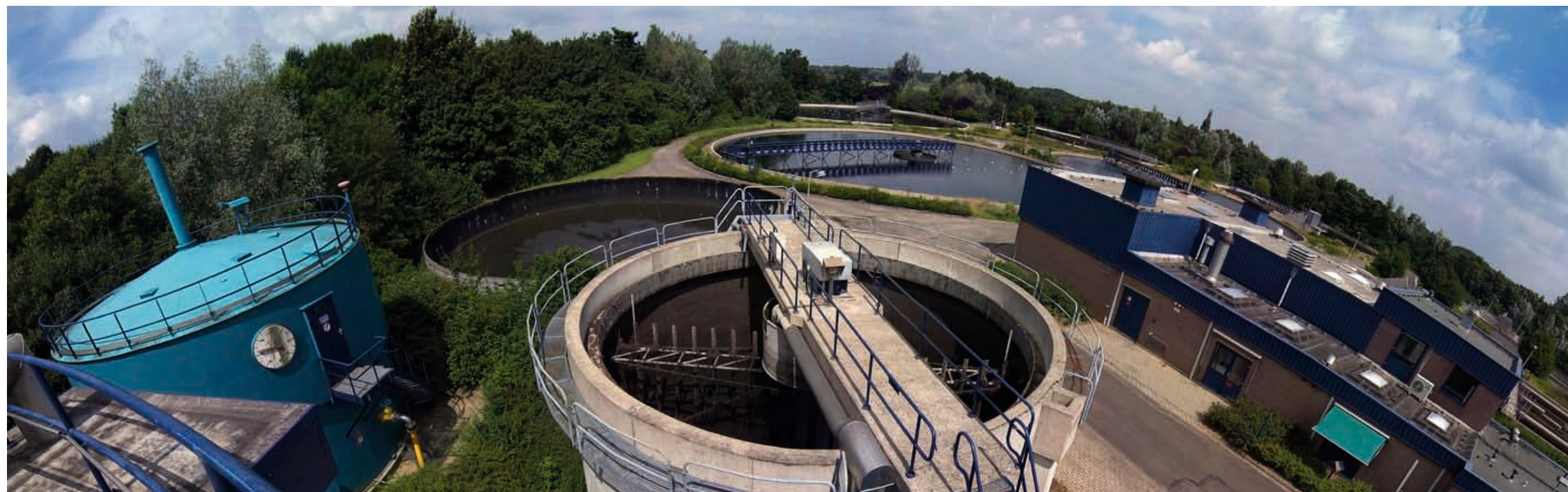
De rioolwaterzuivering in Etten. Hier komt vanuit drie gemeenten het afvalwater van bedrijven en 130.000 bewoners terecht.
